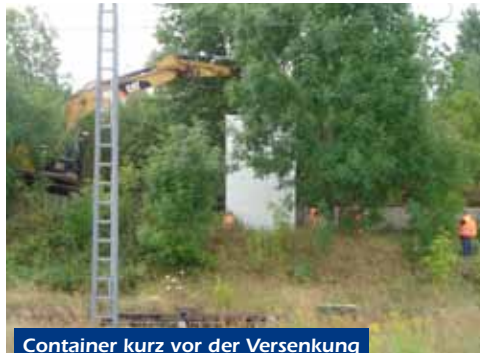
Container kurz vor der Versenkung
